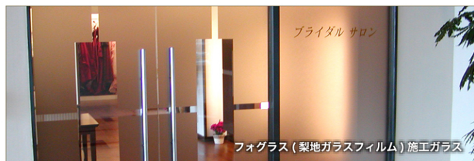
ダイノックシート施工風景
